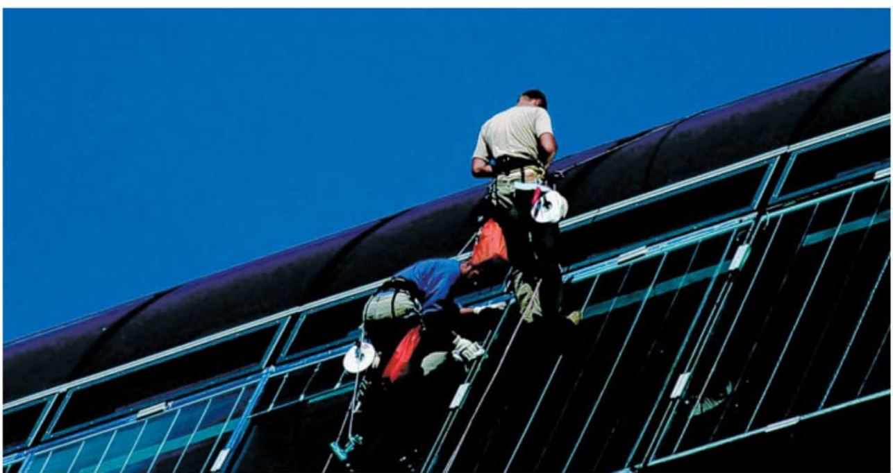
Fassadenreinigung: In schwindelnder Höhe gehen die Reinigungsfachkräfte zu Werke.
